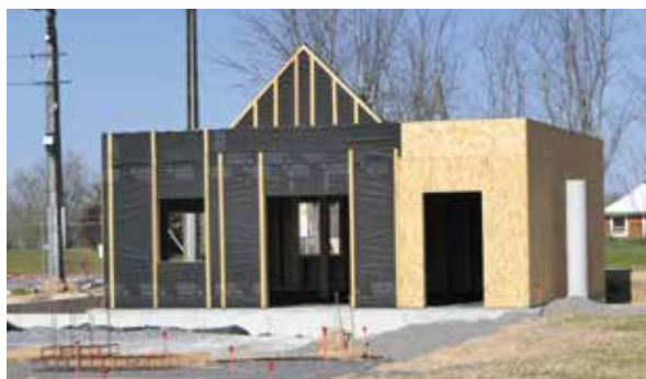
Début des travaux du bâtiment accueil
